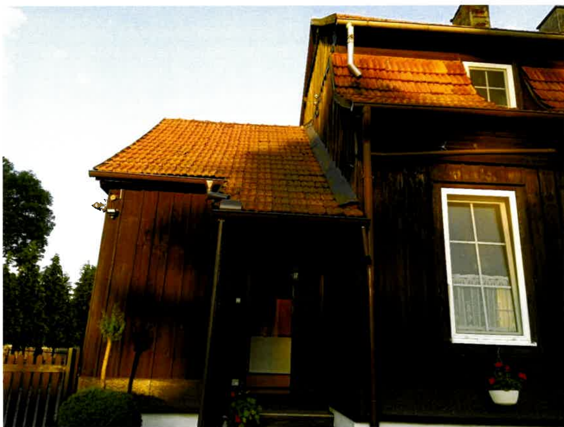
Fot.7 Zespół kościoła pw. Św. Mikołaja w Chróście, plebania, wejście do przybudówki, elewacja tylna.
