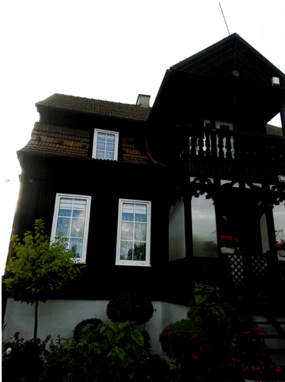
Fot.3 Zespół kościoła pw. Św. Mikołaja w Chróście, plebania, zbliżenie części frontowej z gankiem od strony półn-zach.
