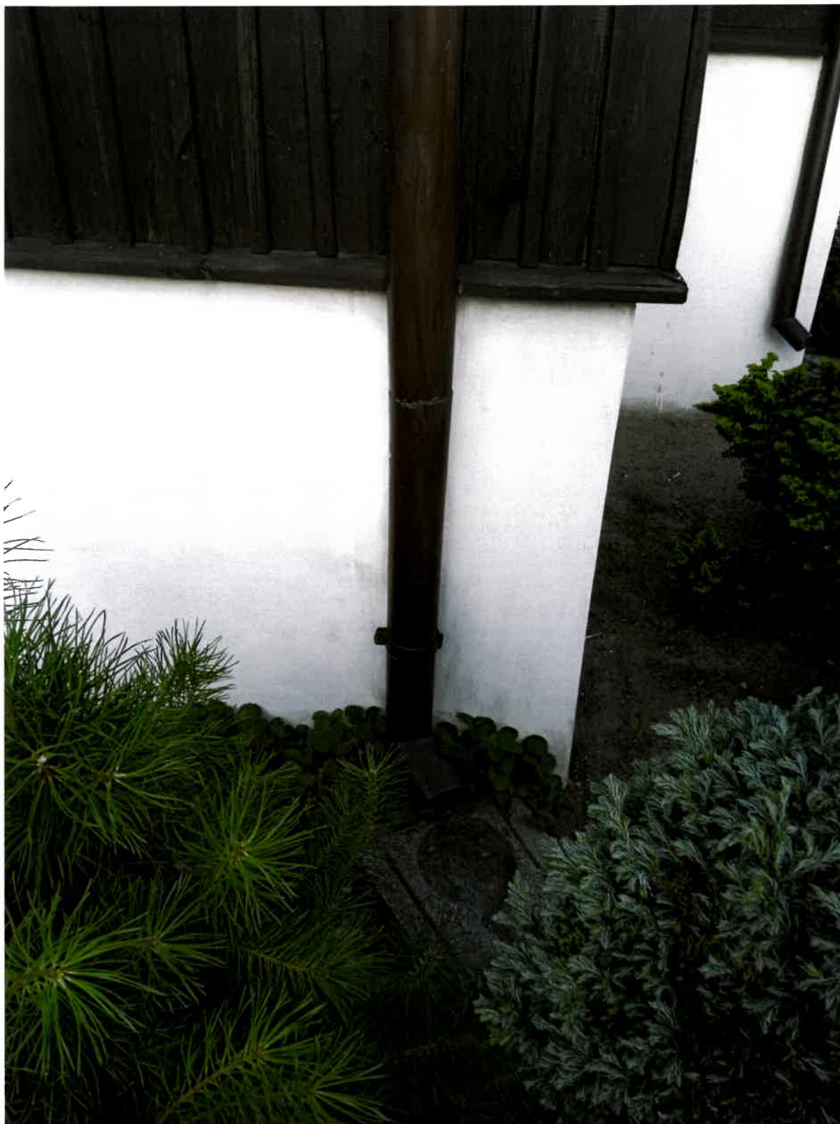
Fot.8 Zespół kościoła pw. Św. Mikołaja w Chróście, zbliżenie otynkowanego cokołu oraz dolnej partii szalunku. Stan dobry.
